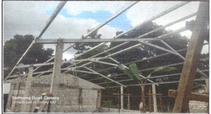
Foto 2: Se observa el avance de la estructura del techo de las dos aulas.
