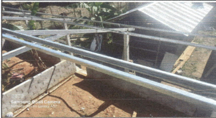
Foto 1: se observa el inicio de la estructura de techo
