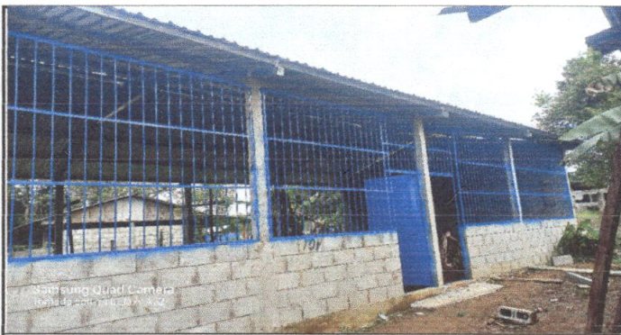
Foto 5: Se observa la colocación de puertas y balcones.
