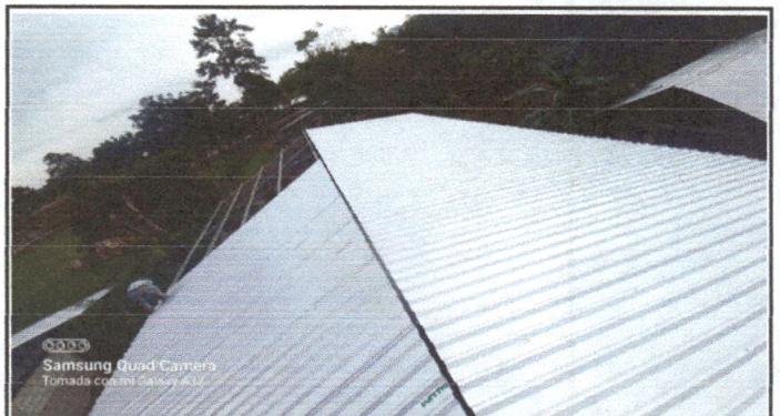
Foto 4: Se observa la colocación de las láminas.
